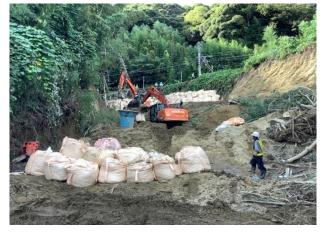
土気~大網駅間 土砂流出箇所復旧作業の様子(写真向かって左側が土気駅方向)
